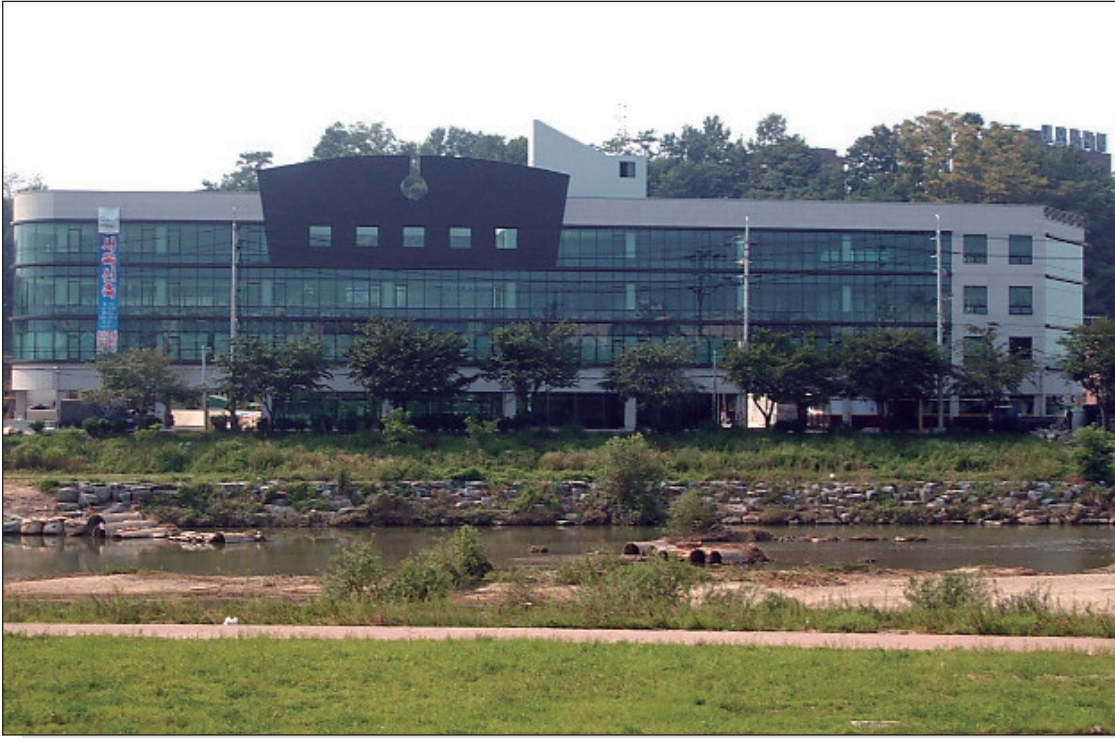
오산 에버테크 공장 및 연구소 신축공사
