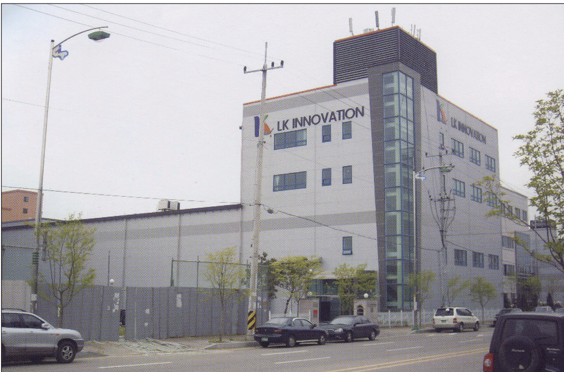
수원 고색동 임광엔지니어링 공장 신축공사
