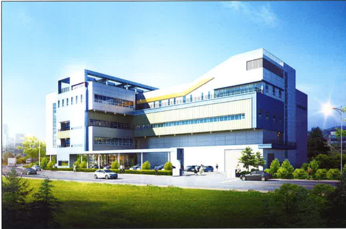
(주)에이앤아이 사옥 및 공장 신축공사
