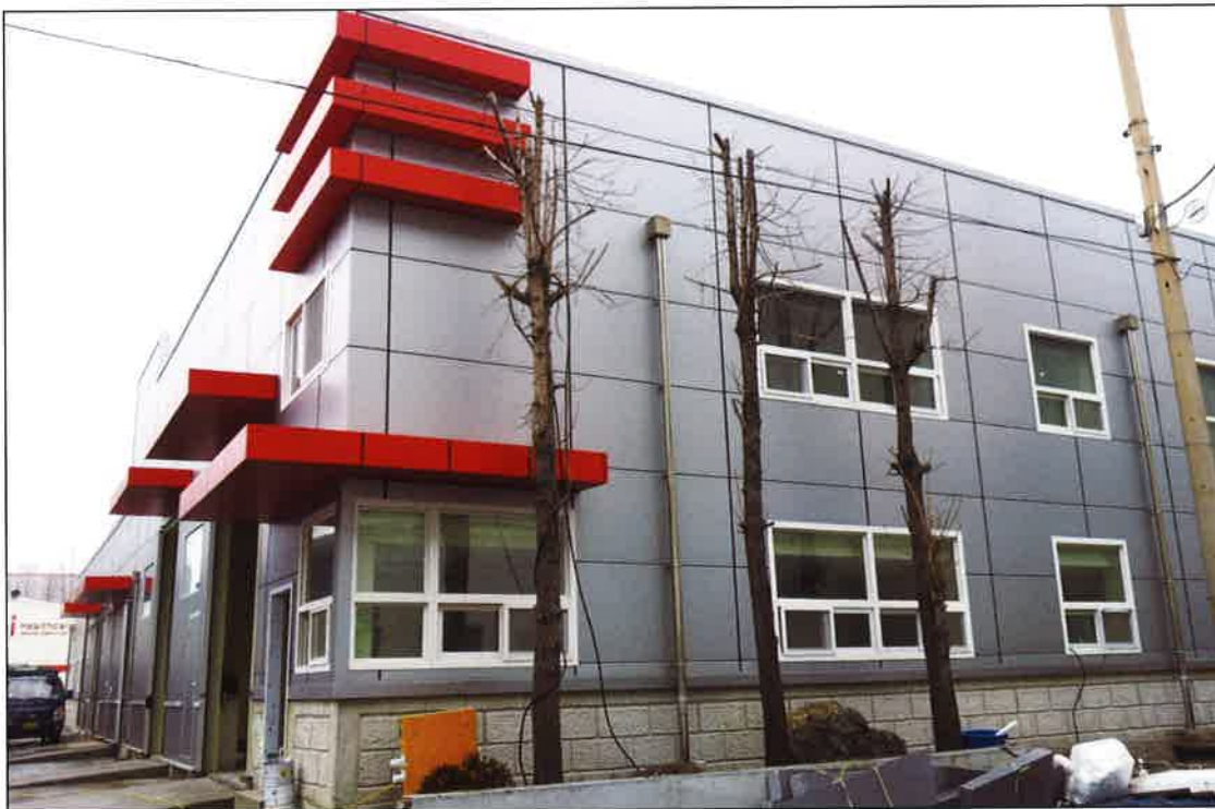
JPI헬스케어(주) 안산공장 증축공사
